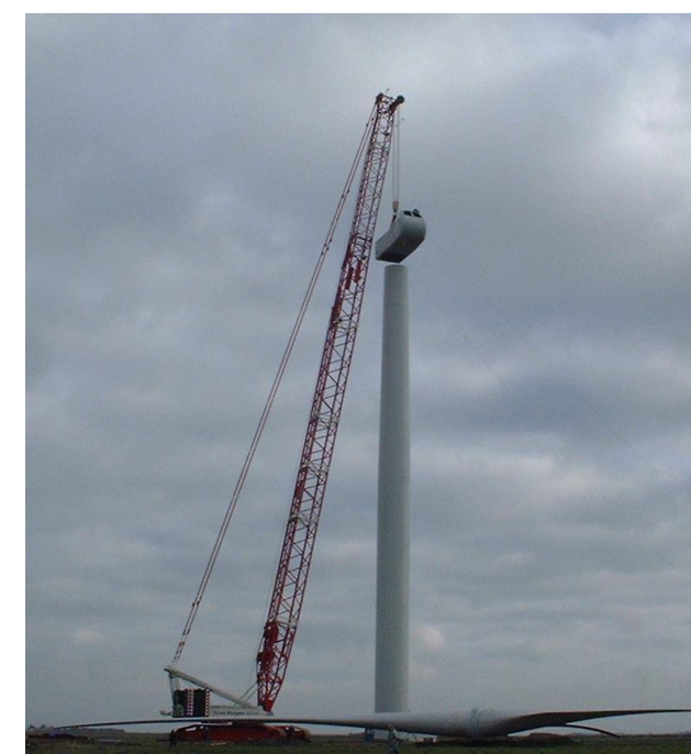
Montage de la nacelle
